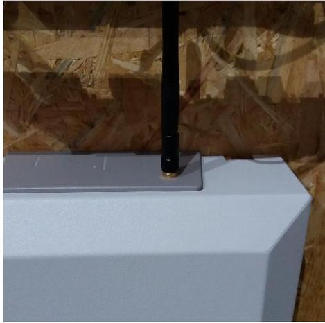
**Abbildung 25: Montage der Antenne für ALI an Fernmeldekasten**
