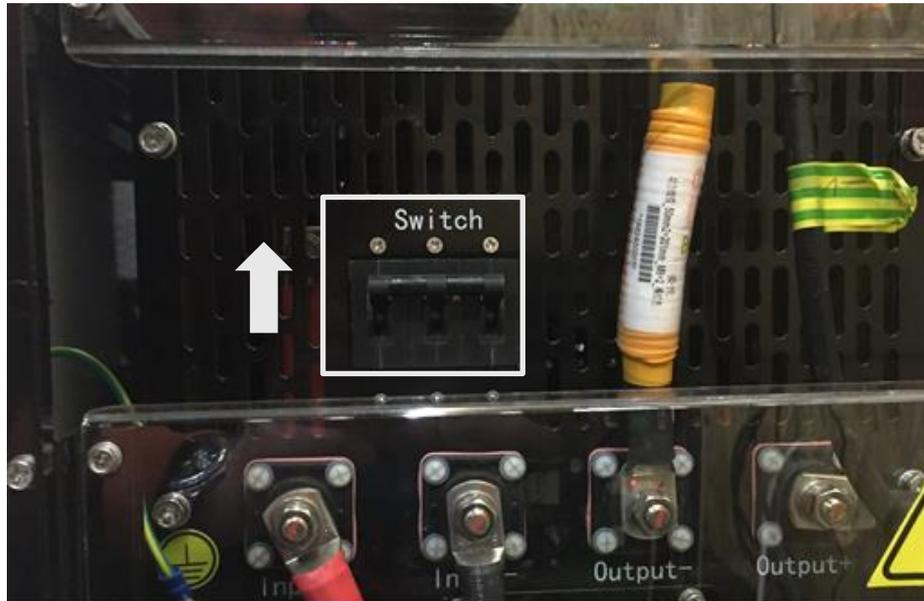
Abbildung 32: Einlegung des DC Trennschalters
