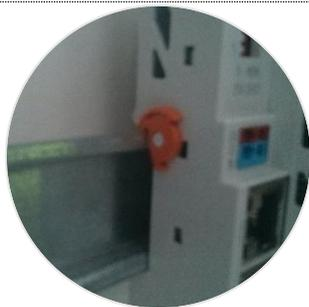
**Fixieren** Sie den Feldbuskoppler mithilfe der **orangenen Verriegelungsschraube** auf der Hutschiene.
