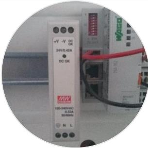
Platzieren Sie das **MEAN WELL Schaltnetzteil** auf der Hutschiene.
